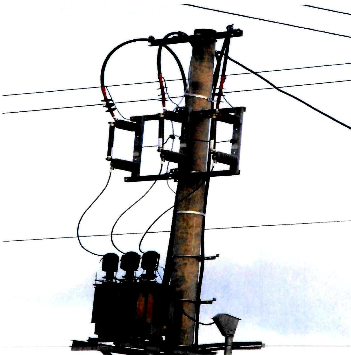
Слика 11. Трансформери / изоловане жице за препошћавање ("jumper wire") + пластичне капе за изолаторе
