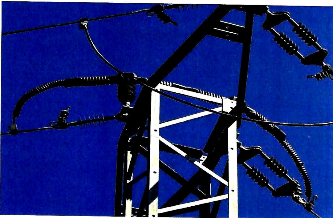
Слика 7. Изглед постављених пластичних „капица“ изолатора
